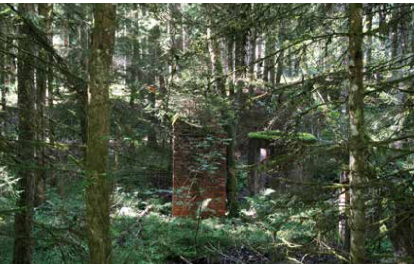
◀ Dampfkesselanlage außerhalb des Gedenkpfades Eckerwald Restes de la chaudière à vapeur à l'extérieur de Eckerwald Fleig, Sina; Gymnasium Gosheim-Wehingen
