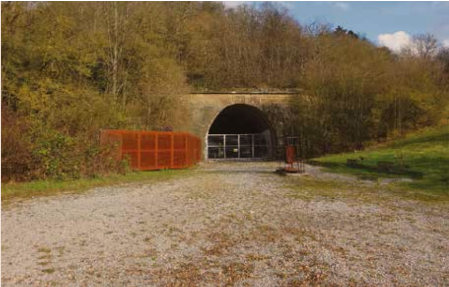
Blick auf den Eingangsbereich des Tunnels La vue sur l'entrée du tunnel
