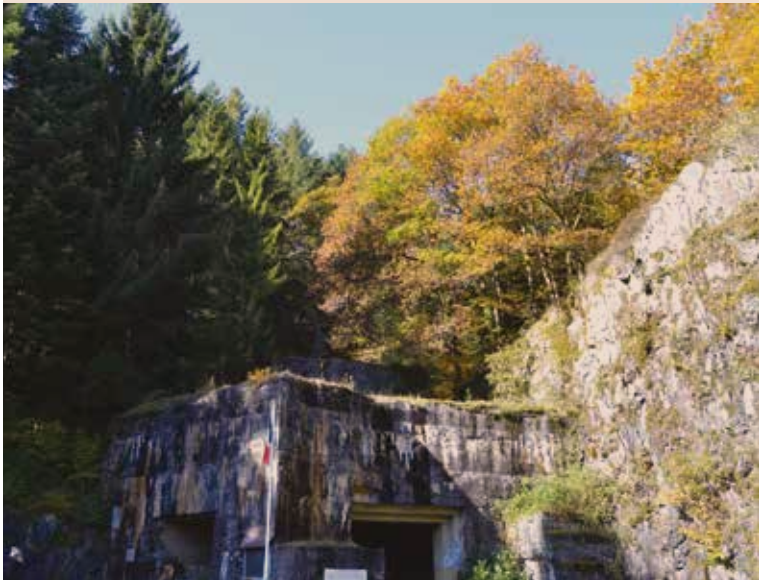
Site du camp annexe d'Urbès - Le pont face au tunnel d'Urbès - Stätte des Aussenlager von Urbès - Die Brücke gegenüber vom Tunnel
