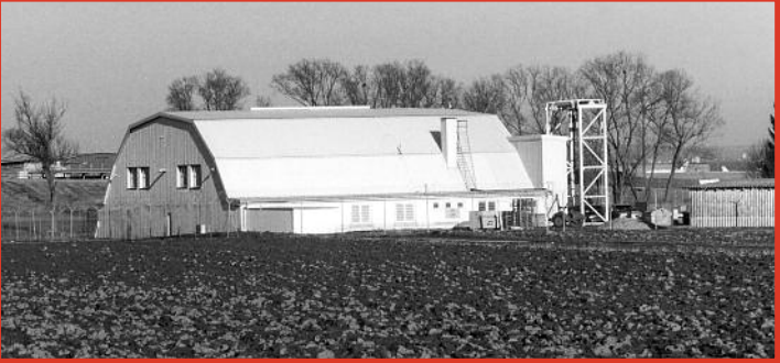
Hangar sur le terrain d'aviation d'Echterdingen. Hangar auf dem Militärflughafen Echterdingen. © KZ-Gedenkstätte Echterdingen-Bemmann
