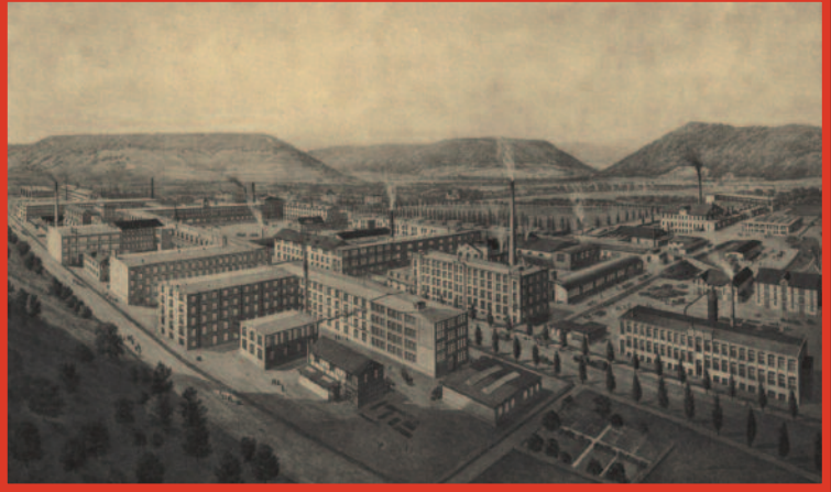
Usine métallurgique de Geislingen/Steige. Württembergische Metallwarenfabrik WMF Geislingen/Steige. © Coll. Arno Rühl
